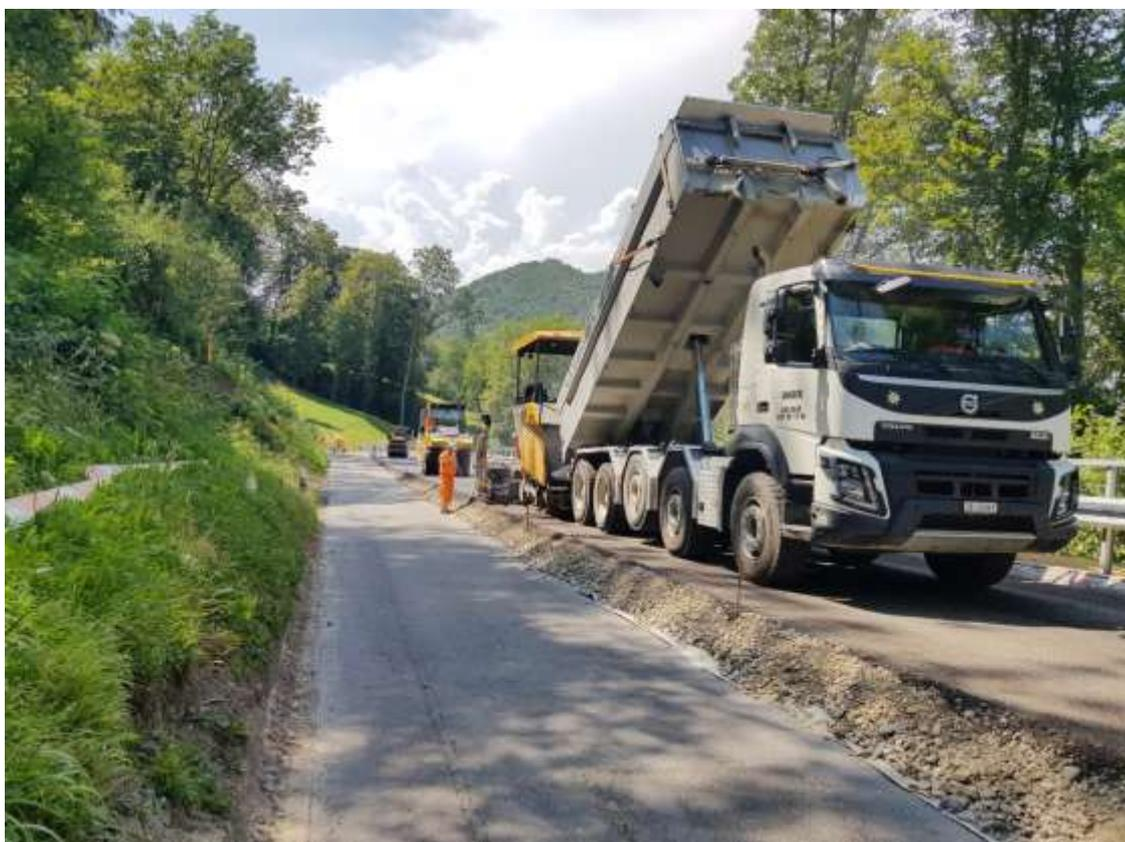
In diesem Abschnitt wurden zwei Stützmauern erstellt. Dazu musste vorgängig Mikropfähle für die Verankerung der Stützmauer gebohrt werden. Der Belag wurde diese Woche eingebaut.
